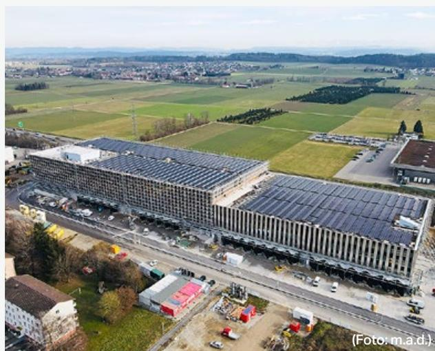
Fotografia aerea del CSO e del suo impianto fotovoltaico sul tetto con orientamento nord-sud. (Foto: m.a.d.)
