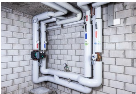
Überblick über die neue Anlage (ganz oben), Touchscreen der Steuerung (Mitte) sowie die neue Heizgruppe im Wohnhaus.
