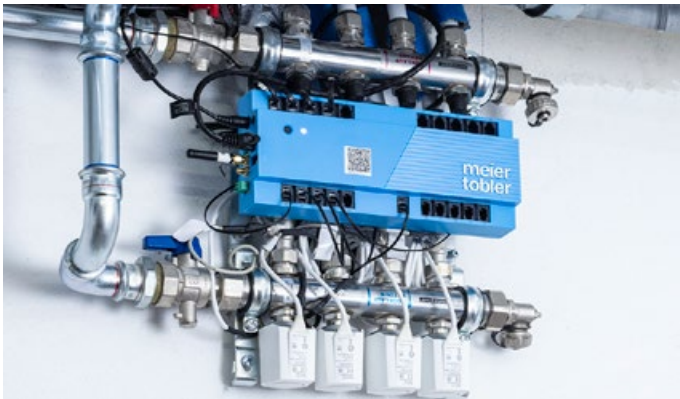
Die neue Anlage in Dario Giovanolis Haus (oben) mit der Luft-Wasser-Wärmepumpe Mitsubishi Electric Ecodan von Meier Tobler, dem neuen 300-Liter Oertli Heizspeicher sowie dem neuen 400-Liter Oertli Warmwasserbereiter (links oben). Grossaufnahme des blauen SmartComfort-Verteilers (links).
