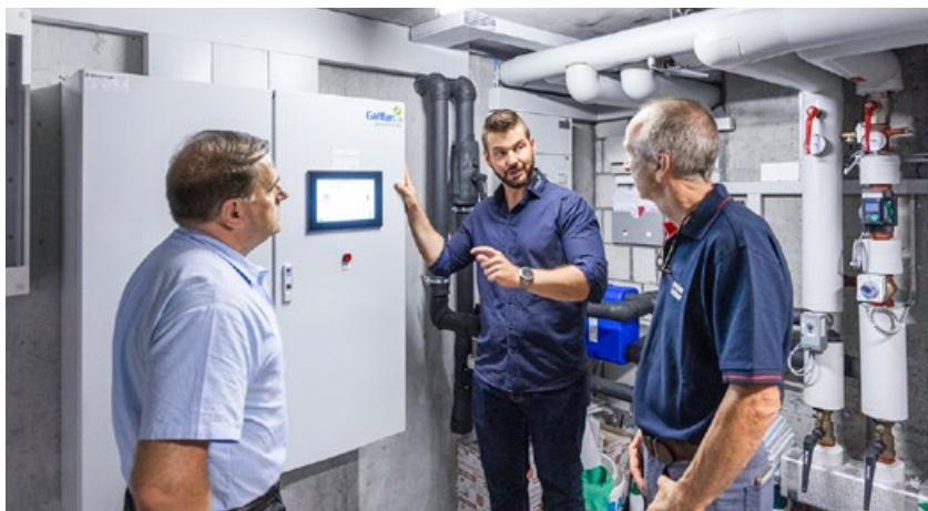
«Das Hirn des ganzen Systems» – Patrik Escher (Mitte) mit Werner Zurkirchen (links) und Leander Tscherrig (rechts) bei der Steuerungsanlage.
