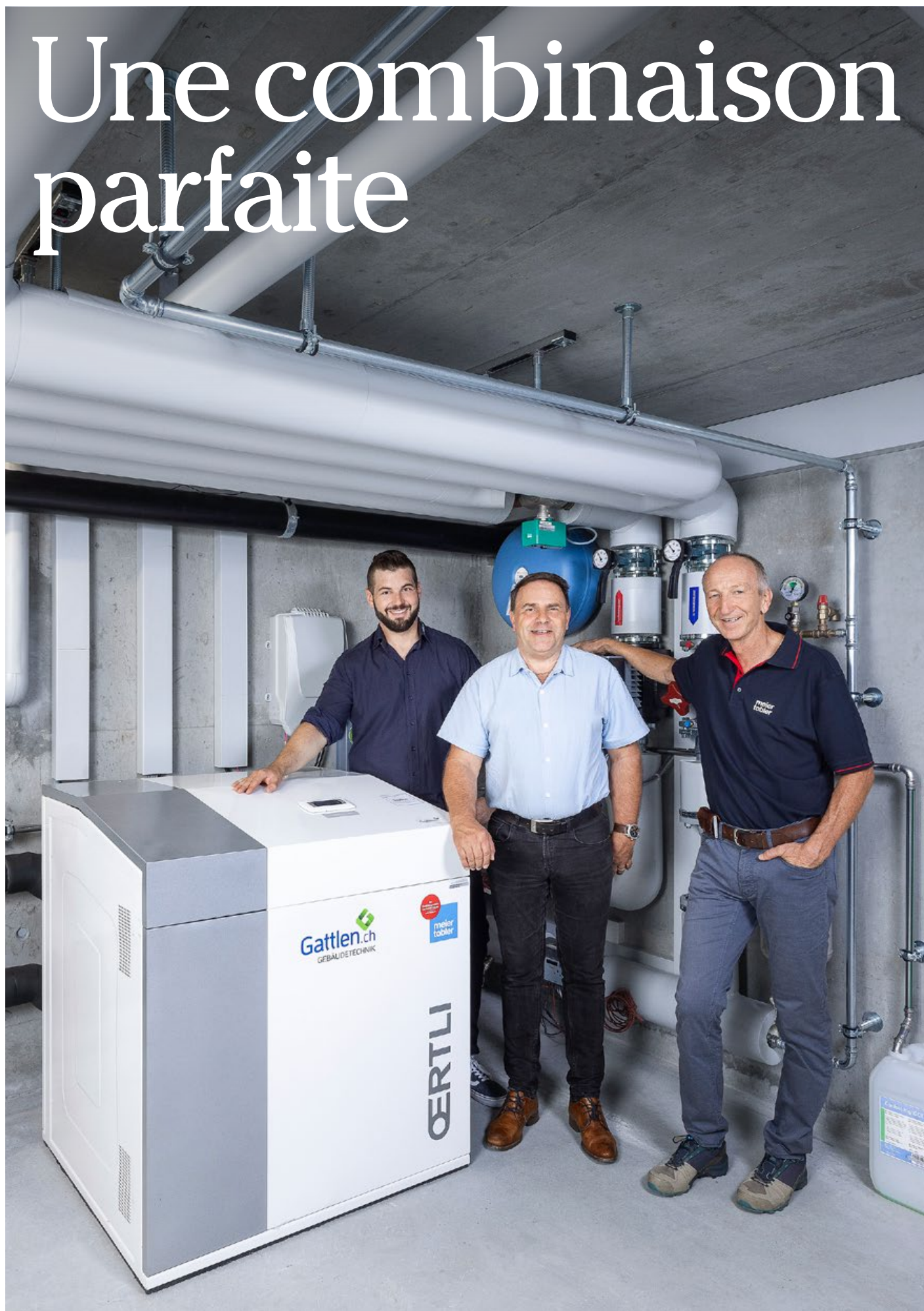
Une rénovation de chauffage réalisée avec succès (de g. à d.): Patrik Escher, Werner Zurkirchen et Leander Tscherrig avec la pompe à chaleur Oertli SI-GEO 25-100. (Photos : rl)
