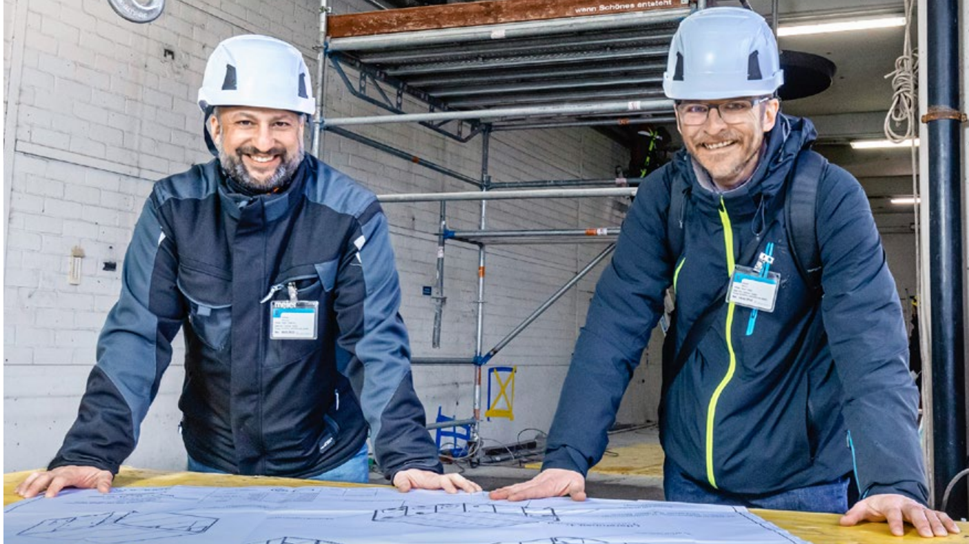
Prêts pour l'arrivée des nouvelles tours de refroidissement : Maurizio Anfuso (à gauche) et Martin Höchli. (Photos : rl)
