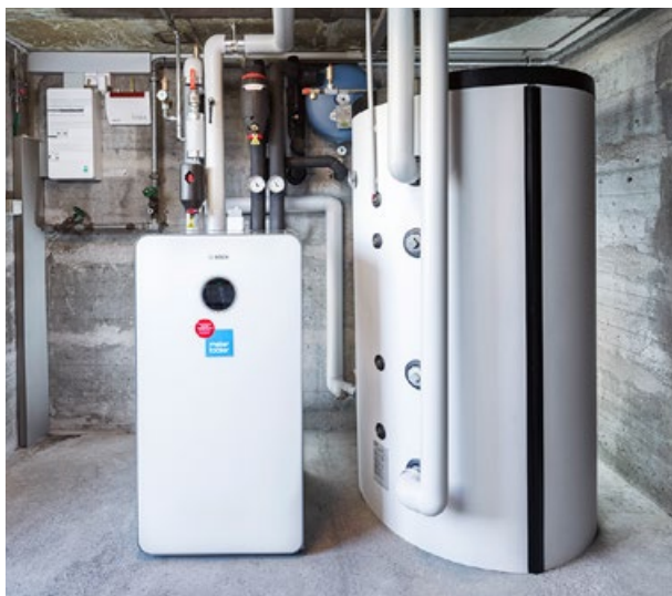
Pompe à chaleur sol-eau CS7800i 12 LW de Bosch (à gauche) avec accumulateur d'eau de chauffage SHW 807 d'Oertli.
