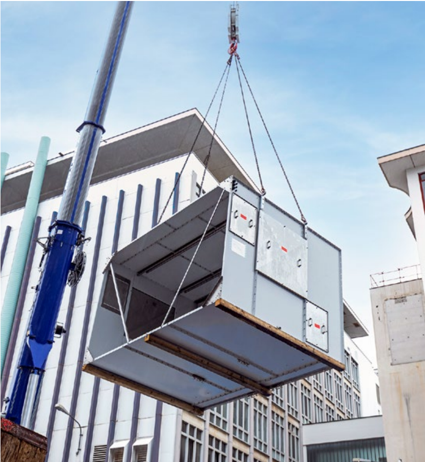
La mise en place du capotage des ventilateurs (ci-dessus) a été suivie par celle des trois ventilateurs eux-mêmes (en haut à droite), qui ont ensuite été ajustés avec précision (au centre) et reliés avec l'habillage (ci-contre).
