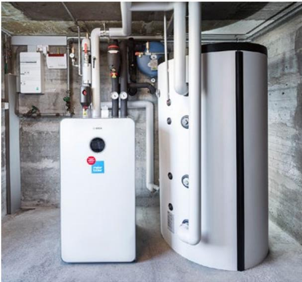
Bosch CS7800i 12 LW Sole-Wasser-Wärmepumpe (links) mit Oertli SHW 807 Heizwasserspeicher.
