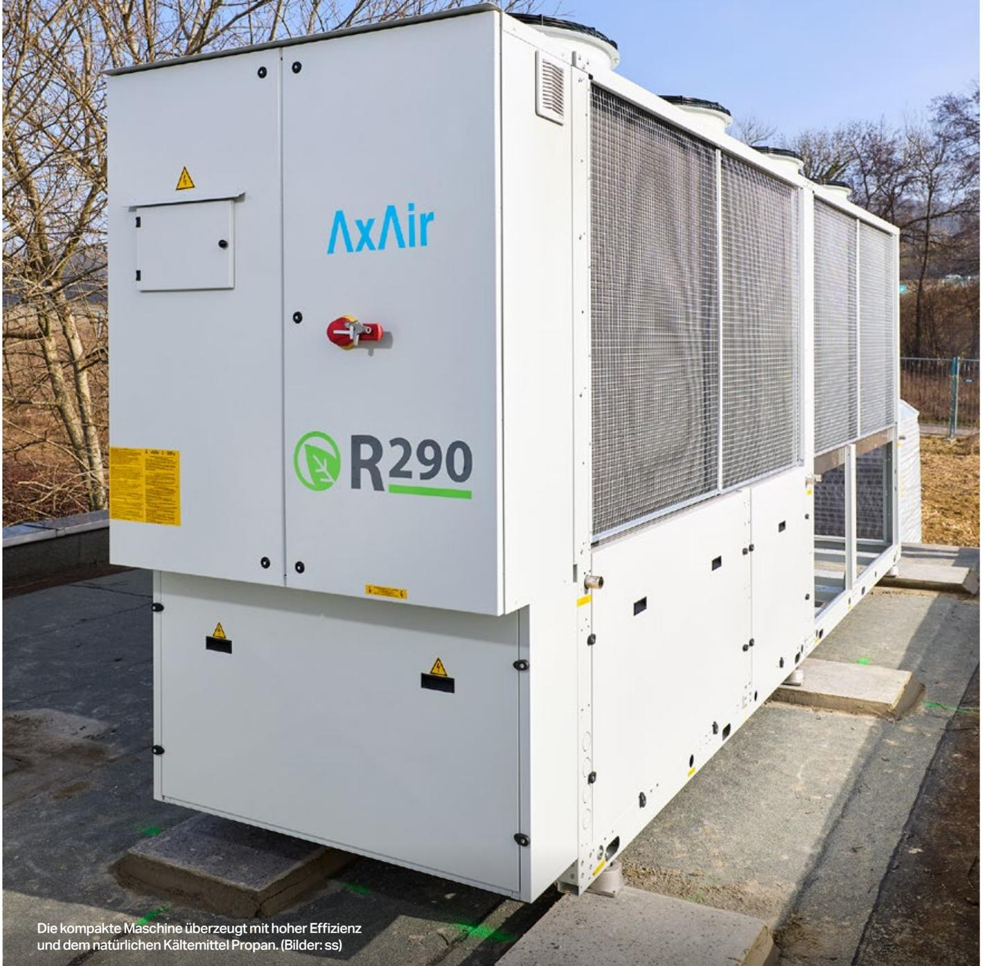
Die kompakte Maschine überzeugt mit hoher Effizienz und dem natürlichen Kältemittel Propan. (Bilder: ss)
