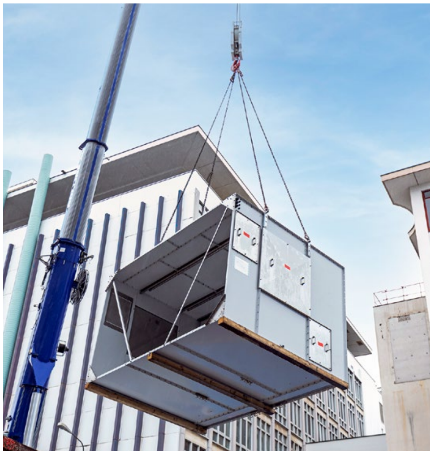
Prima è stata posata la carenatura del ventilatore (sopra), seguita poi dai tre ventilatori (in alto a destra), che sono stati quindi montati con precisione (al centro) e collegati alla carenatura (in basso a destra).
