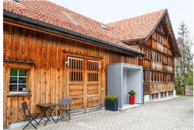
Ristrutturazione: casa contadina a Hundwil (AR).
