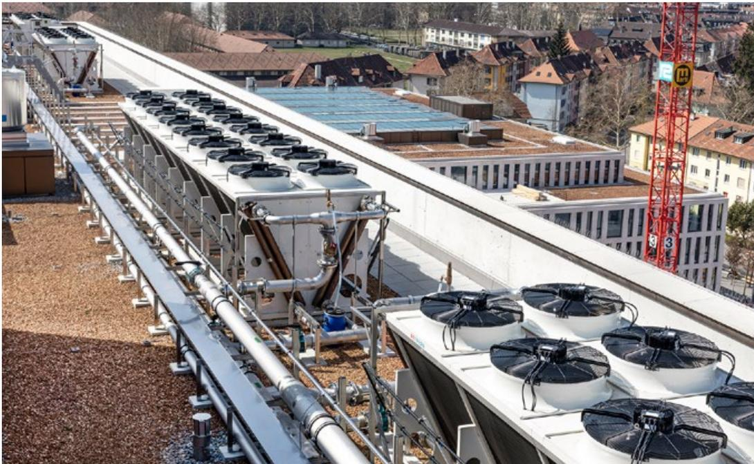
Sur le toit du bâtiment principal sont installés les aérorefroidisseurs Refrion (ci-contre).
