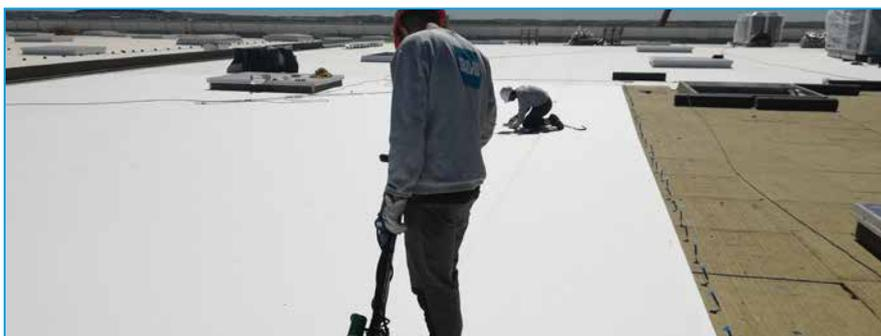
As membranas em poliolefina termoplástica de alta resistência foram seladas entre si utilizando um soldador automático de ar quente com unidade de aquecimento e bocal para membranas **TPO** e um rolo de pressão.
