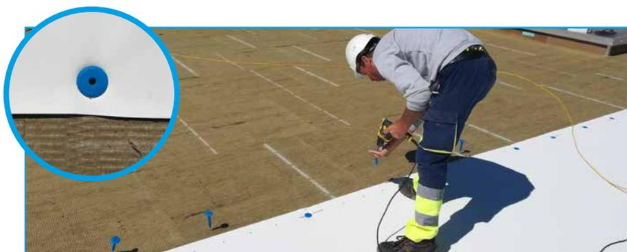
A membrana **EverGuard TPO** foi fixada, juntamente com os painéis de lâ de rocha, utilizando parafusos de aço protegidos e cânulas de fixação. Este tipo de fixação mecânica oferece uma excelente resistência contra a força do vento.
