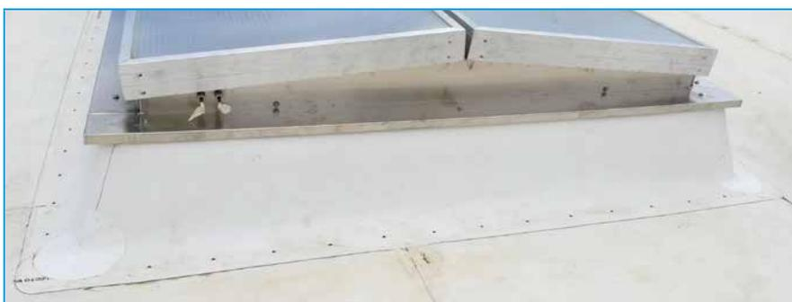
Os pontos mais sensíveis, por exemplo, uniões ou cantos, foram reforçados com a aplicação de peças pós-formadas específicas em **TPO**, soldadas por termofusão a ar quente.
