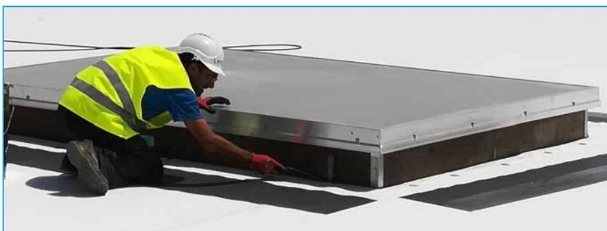
Para drenagens, clarabóias e outros pontos particulares do telhado, foi utilizada uma banda de remate de **TPO** que foi fixada às superfícies utilizando o adesivo de contacto específico para **TPO** e com fixação mecânica no seu ponto alto.
