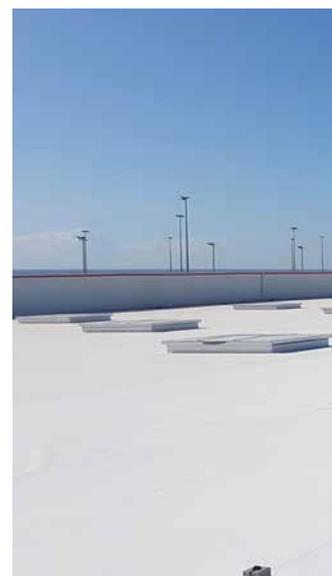
**O sistema EverGuard é um sistema monocamada de fixação mecânica completo, para a impermeabilização de coberturas não transitáveis com uma inclinação a partir de 1%.**
