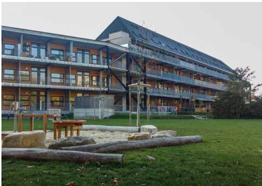
BWSG-Wohnhausanlage in St. Pölten ausgestattet mit dormakaba TIC-Zylindern. Foto © BWSG
