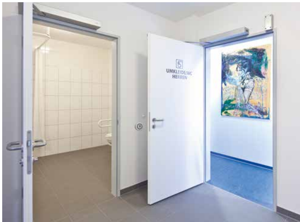
Automatisierte Öffnung durch den Drehtürantrieb ED 100 / ED 250 mit WC-Steuerung
