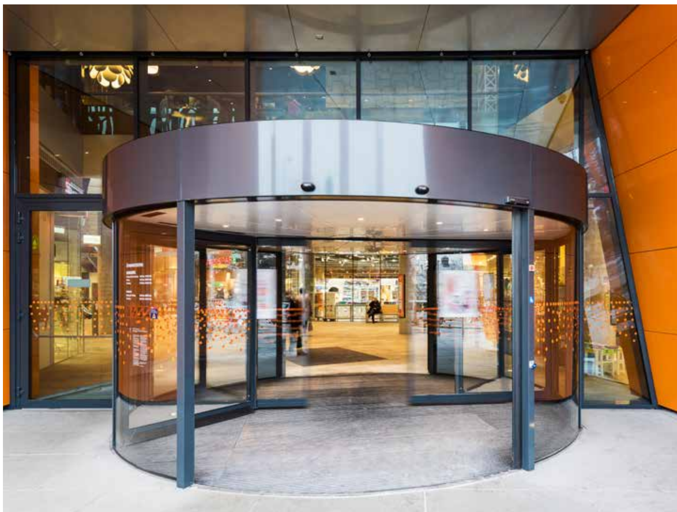
Integrierte automatische Schiebetüranlage
