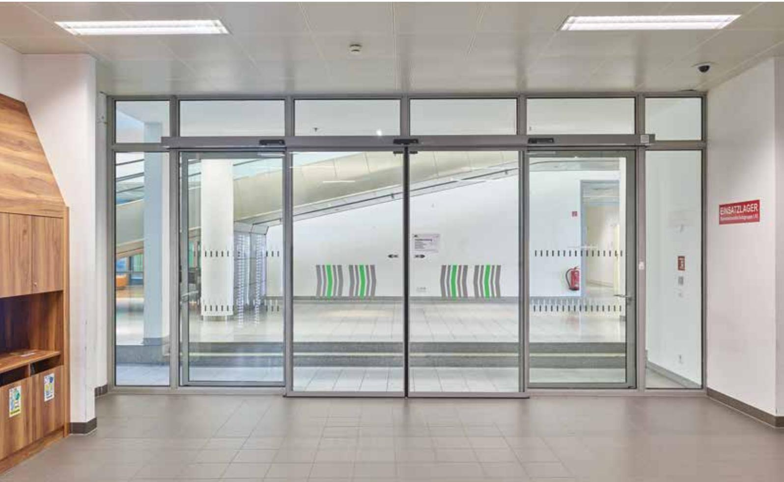
Brandabschnitt mit integrierter Schiebetür ST FLEX
