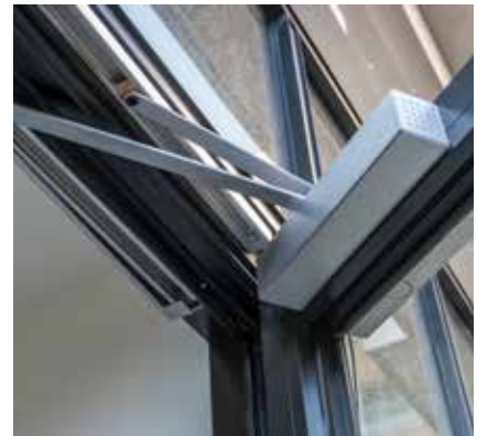
Türschließung gegen Überdruck mit TS 93 auf der Bandgegenseite und Freilauf-türschließer 1) TS 99FL auf der Bandseite
