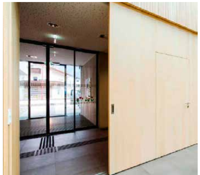
Brandschutzschiebetüre Holz, mit Fluchtfunktion
