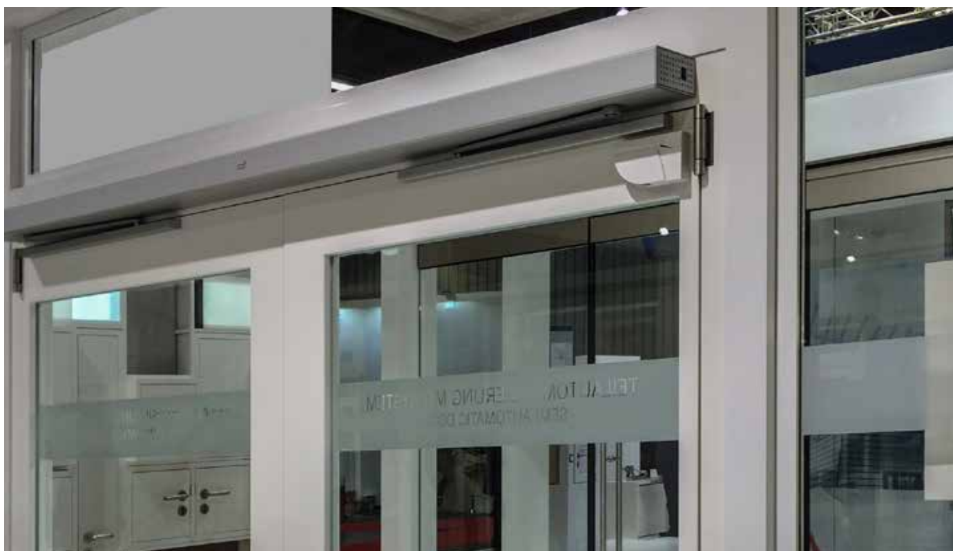
Automatischer Drehtürantrieb mit Flat Scan Absicherung
