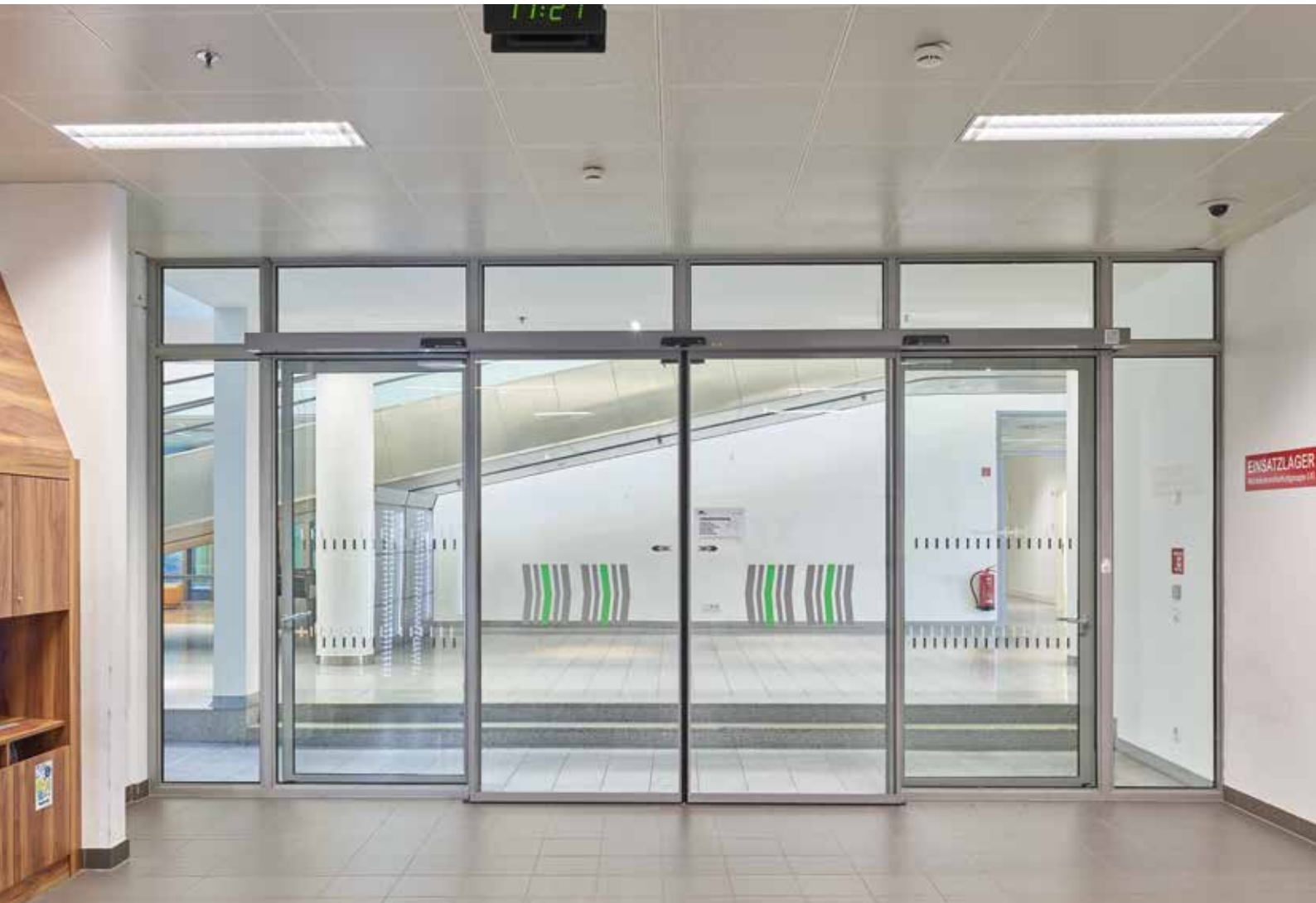
Brandabschnitt mit integrierter Schiebetür ST FLEX
