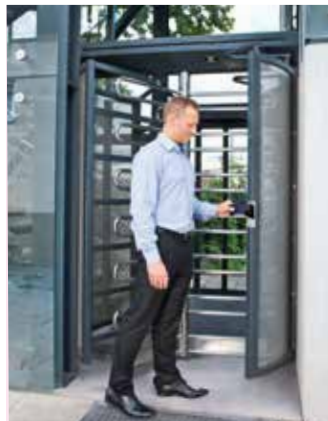
Sicherheit im Außenbereich: die Leser mit abgesetzten Erfassungseinheiten
