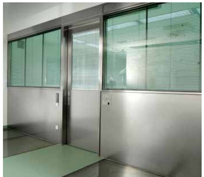
Der Reinraum muss jegliche Kontamination durch Fremdpartikel unterbinden. Edelstahl und Glas sind robust und pflegeleicht und eignen sich daher besonders für Reinraumbereiche
