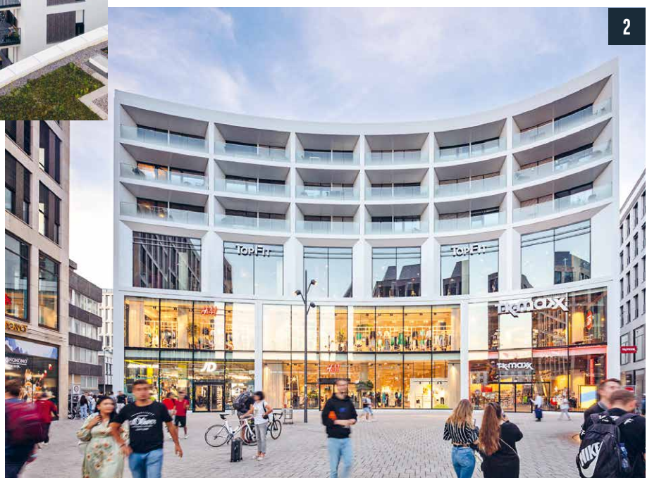
2 — Eingangstor zur Stadt: Zwischen Münster und Hauptbahnhof gruppieren sich 4 Gebäude mit einer Mischnutzung aus Büro, Handel, Gastronomie und Wohnen um den zentralen Albert-Einstein-Platz.
