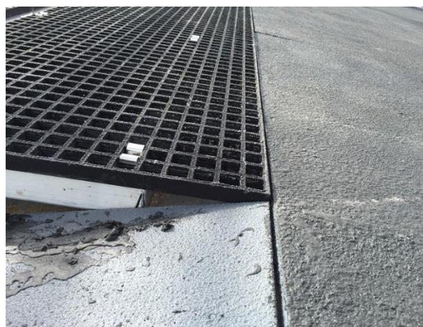
Meilleure pratique d'installation de la grille de départ. Grille légèrement enfoncée pour compenser le léger écart entre la surface de la grille et la surface de la butte de départ.
