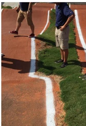
Contrairement à cet exemple, les bords des lignes droites doivent être aussi droits que possible. Les lignes doivent suivre de façon continue le bord roulant de la surface de la piste.
