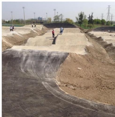
**Ce qu'il ne faut pas faire :** voici deux exemples de virages mal alignés avec les lignes droites. Sur la gauche, la bordure extérieure du virage revient trop vers l'intérieur à la sortie du virage, poussant les coureurs vers l'intérieur. Il devrait être possible d'aborder la ligne droite en suivant la ligne blanche extérieure.
