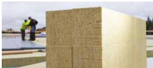
Figur 44: Udlægning af TOPROCK System på ståltrapez.
