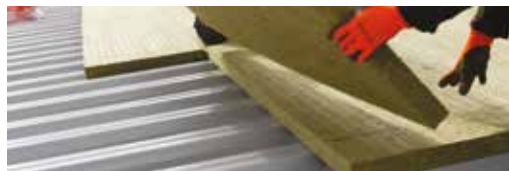
Figur 45: Udlægning af Stålunderlag Energy. Markeringen på pladernes overside angiver hvilken side der skal vende opad.
