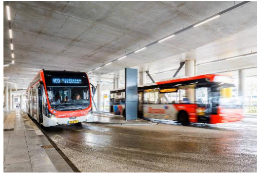
► De busterminal in het multifunctionele P1-gebouw
