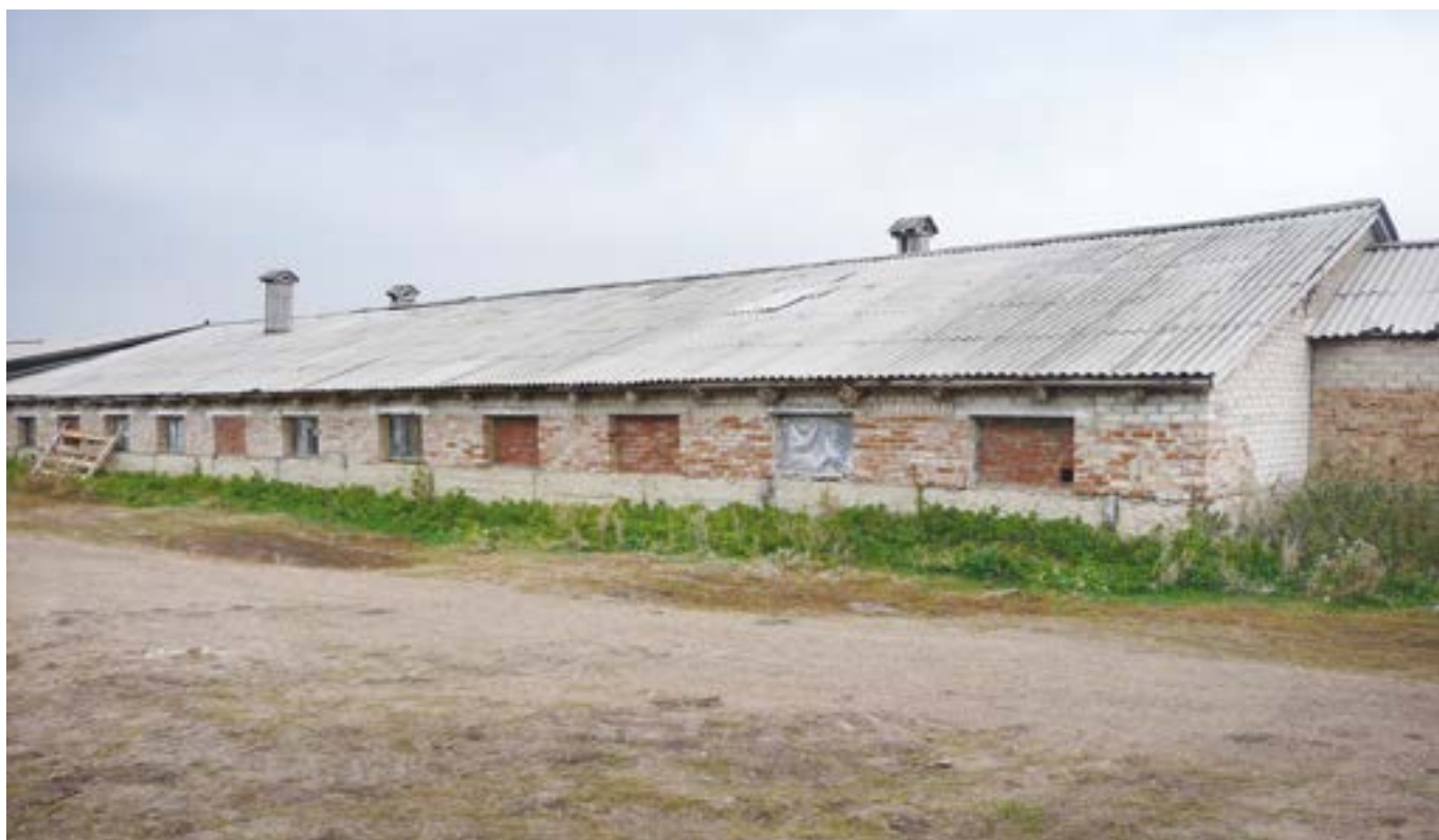
图2.38. 很多陈旧牛棚屋顶采用石棉材料，如果翻新时需要处理这些材料的话，必须小心。来源：国际农业发展基金会。
