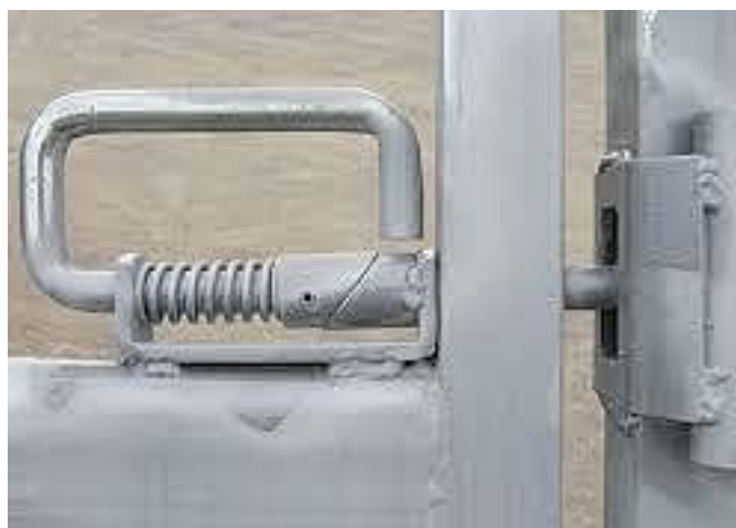
图2.26. 链门和装有弹簧的“大力关闭”门是养牛场大门常用的关闭机关。来源：国际农业发展基金会、Commander Ag-Quip。
