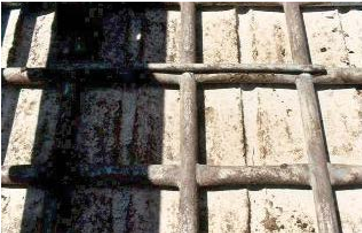
图4.11. 焊管条提供良好的站立处，并降低滑倒、受伤和死亡的机率。来源：澳大利亚牲畜出口公司与澳大利亚肉类及畜牧业公司。
