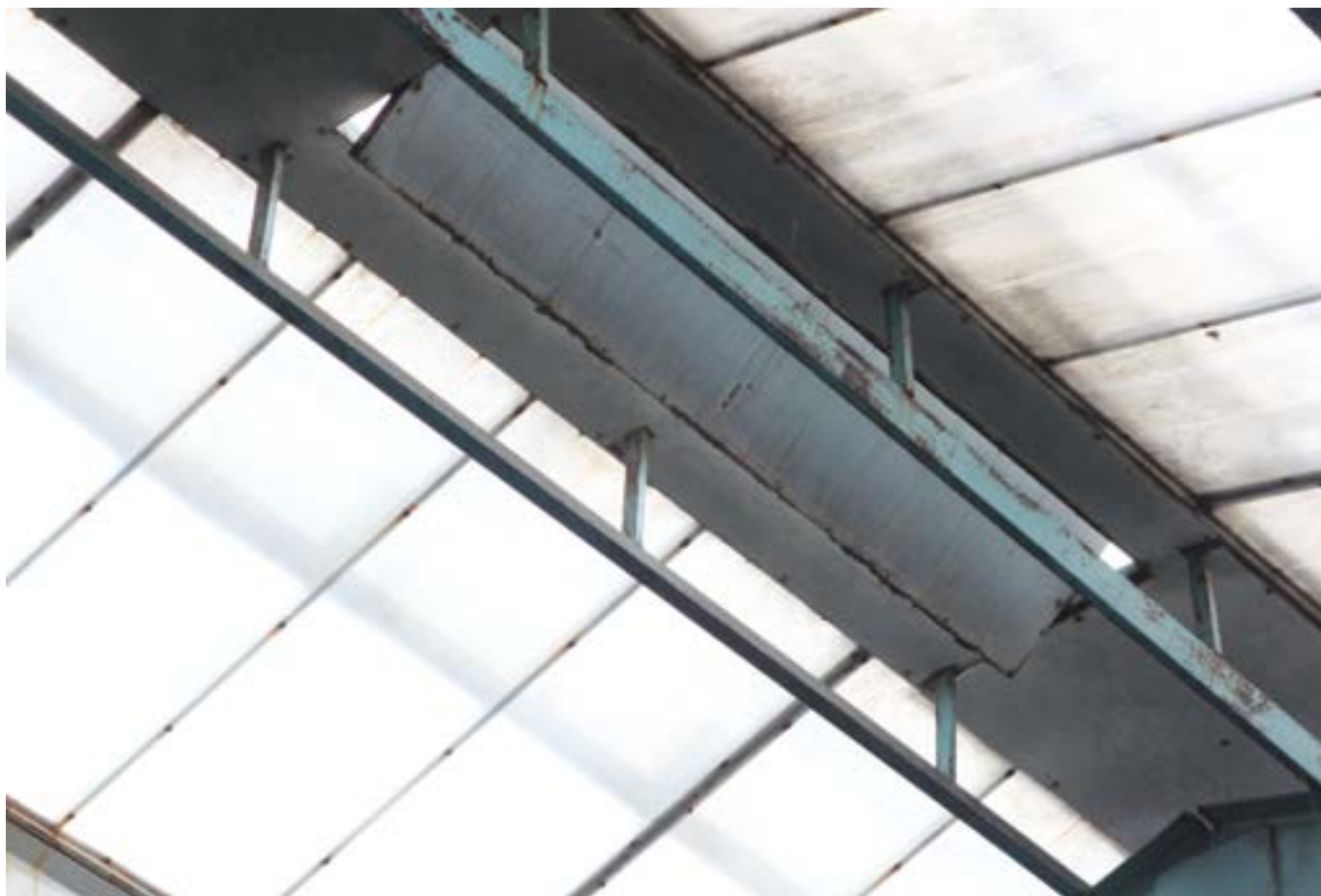
图2.35. 屋顶通风口改善了牛棚通风和空气质量。来源：国际农业发展基金会。
