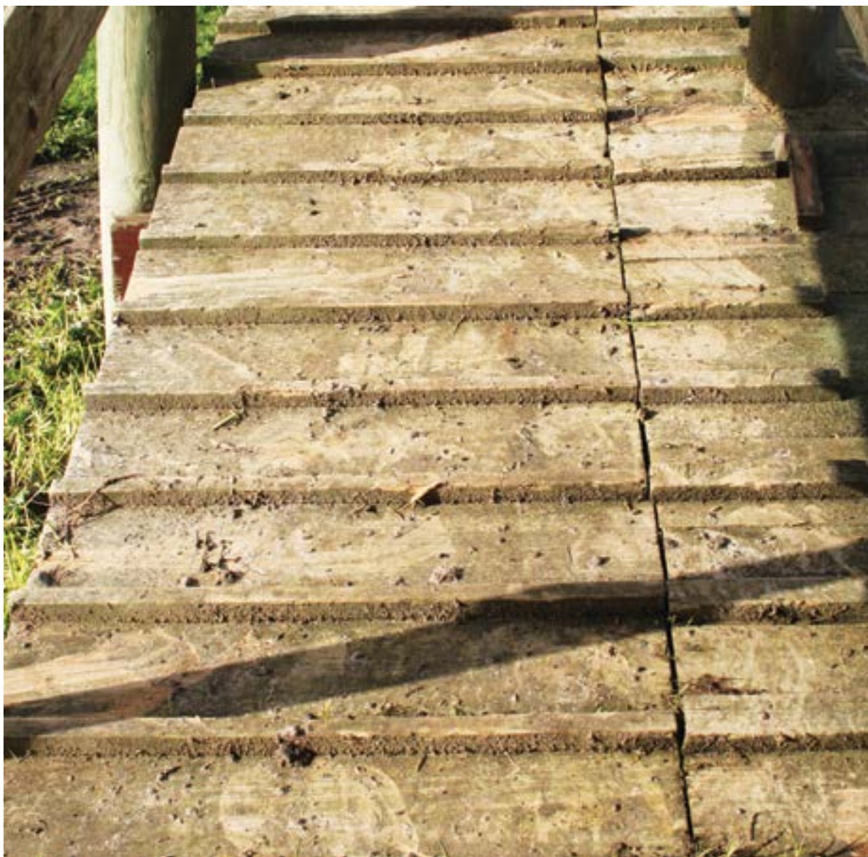
图2.22. 在木制装卸坡道表面横向安装经过处理的细长防滑板条。来源：国际农业发展基金会。
