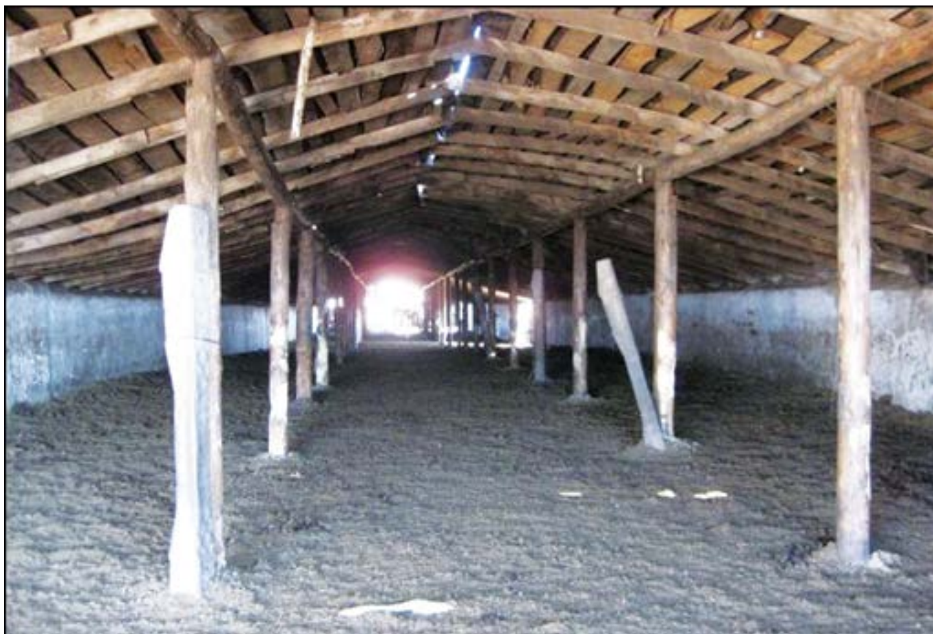
图2.37. 牛棚中的垂直柱子（屋顶支柱）应移除，并对屋顶进行加固，或者在牛棚内设立围栏，从而避免牛只与立柱摩擦。来源：国际农业发展基金会。
