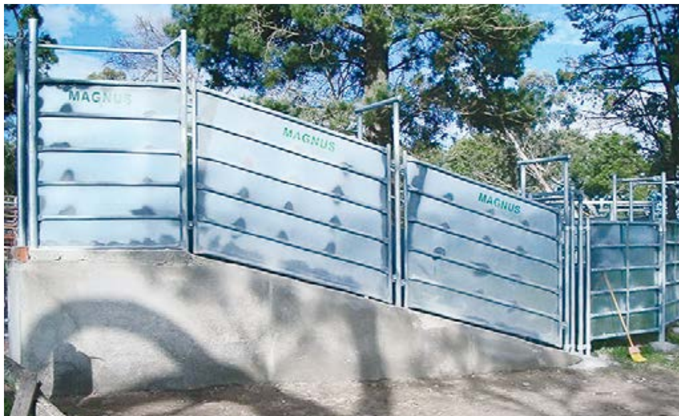
图2.23. 装卸坡道顶端的一个水平平台，便于牛只从卡车上走下来时站稳。来源：Magnus Australia。
