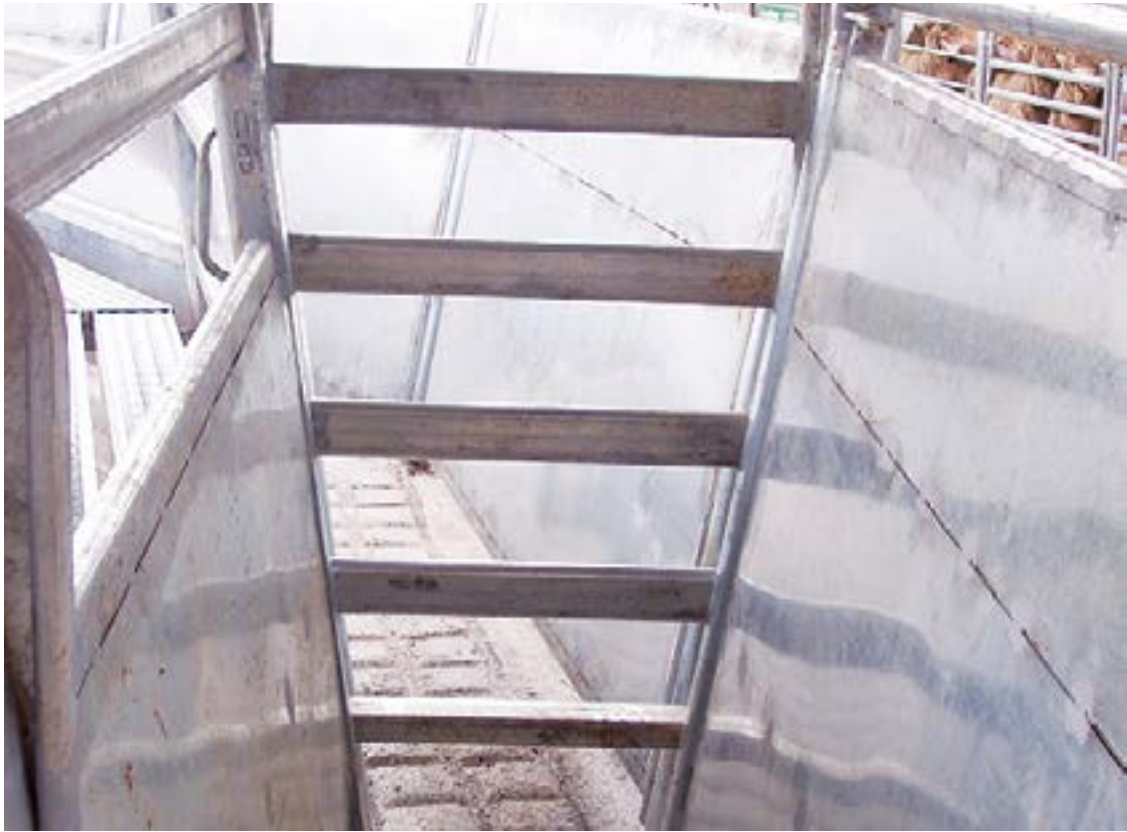
图2.14. 片状V形镶板通道。注意通道混凝土地面的网格形状，用于防止牲畜滑倒。来源：Proway。
