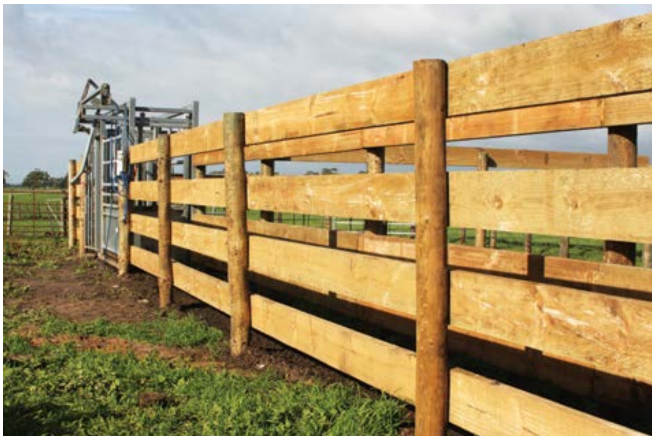
图2.17. 场院木制横杆间距范例。立柱高度1.6米，横杆宽度200毫米，横杆间距200毫米。来源：国际农业发展基金会。
