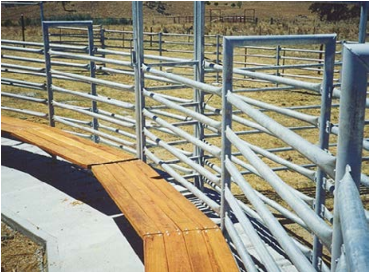
图2.15. 沿通道架高的步行平台，便于接近通道内的牛只。来源：Eco Enterac。
