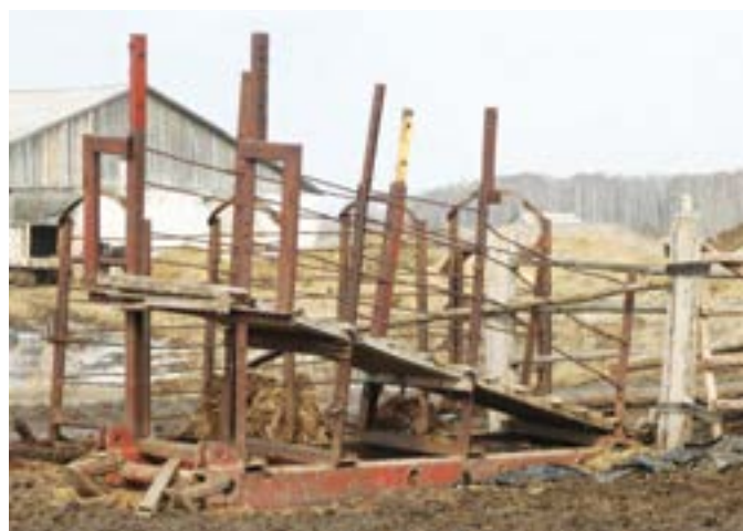
图2.24. 设计和施工不良的装卸设施（如易损坏、两侧较低的装卸坡道，左图）和维护较差的通道（右图）对牛只和人员来说都不安全，必须更换。来源：国际农业发展基金会。
