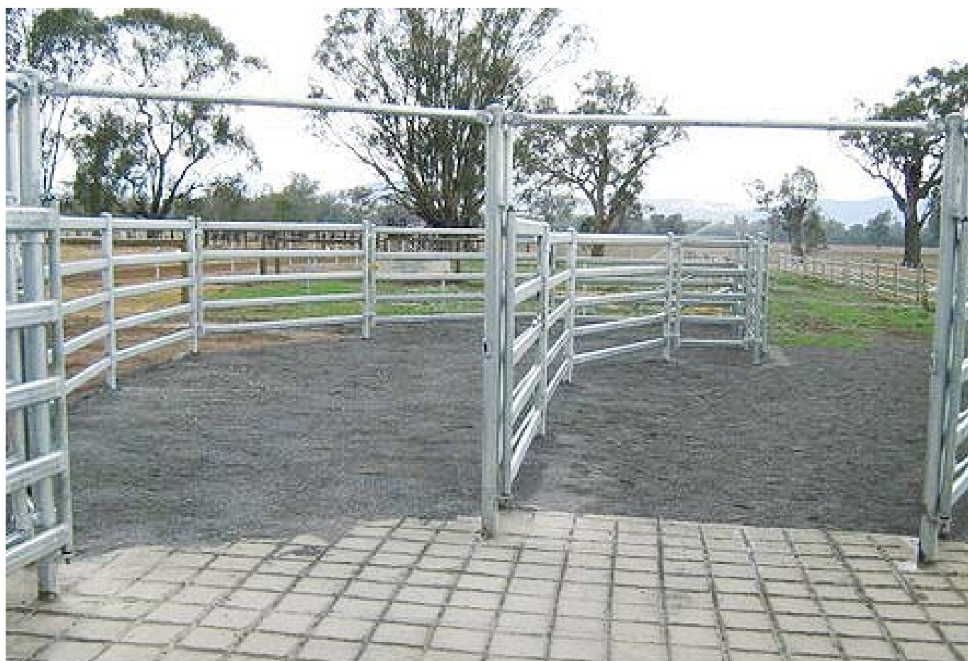
图2.28. 大门上防止门桩倒向两边的顶部栏杆。来源：Proway。
