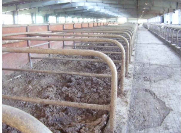
Bu serbest duraklılar kısa ve inekler ayağa kalkmaya çalıştıklarında öne ya da yana hamle yapabilecekleri hiçbir yer yok. Yeterli yatak yok ve mevcut yatak sert. İneklerinin tümünün dışarıda çamurlu bahçede yatmayı seçmesi şaşırtıcı değil.
