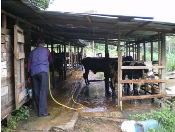
Bu çatının alçak ve sığ eğimi, yaz aylarında ahır çok sıcak yapar ve ısı stresine yol açar.
