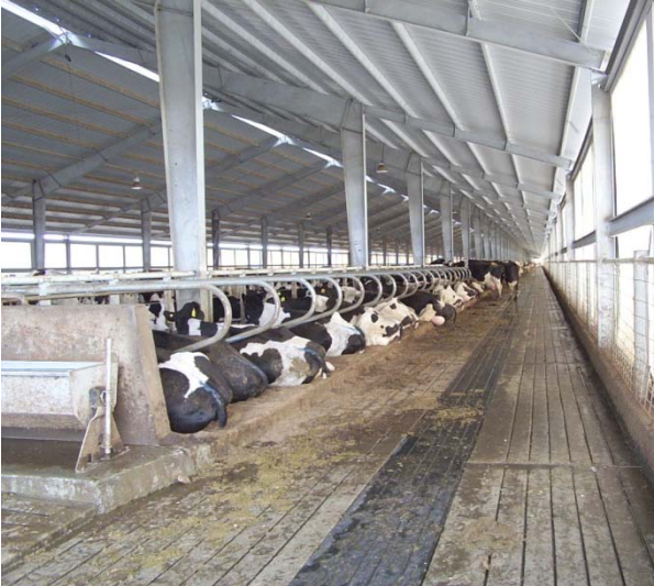
Yan perdelerle serbest duraklı bir ahırda perdeler ahır sıcak tutmak için kapatılmış. İdrar kanalında, ahırın uzunluğu boyunca giden ineklerin rahatı ve ineğin ayağında daha az aşınma için kauçuk bir mat var.
