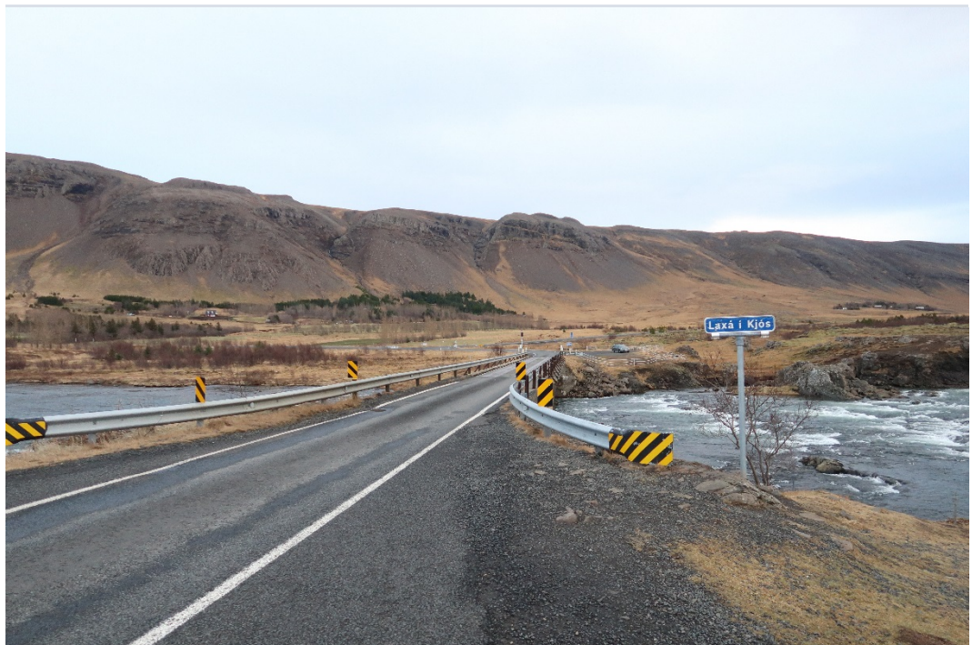
Mynd 3.5 Einbreið brú yfir Laxá í Kjós.
