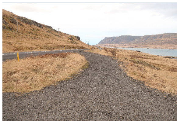
Mynd 3.2 Áningastaður við Hestaþingshól. Ómalbikaður, brotnir vegkantar og lítið rými fyrir rútur.
