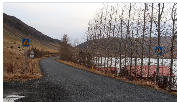
Mynd 3.8 Gangbraut yfir Meðalfellsveg. Það vantar yfirborðsmerkingu en í vettvangsskoðun hafði nýlega verið malbikað.
