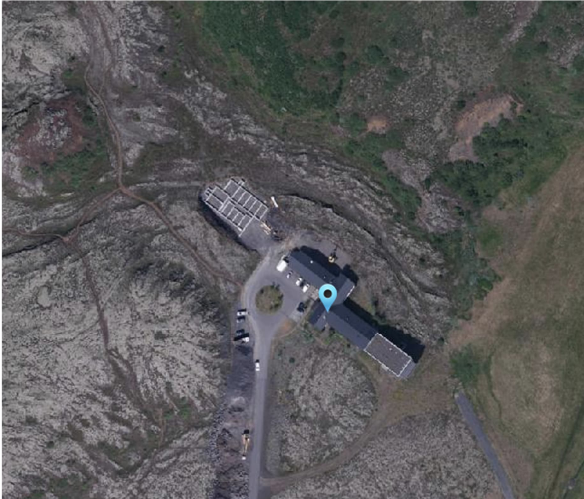
Mynd 5.4 Loftmynd af framkvæmdarsvæði frá árinu 2023
