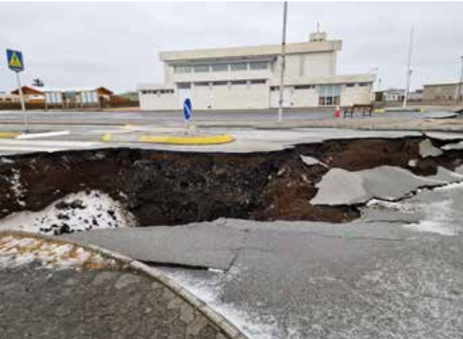
Mynd 1 Sprunga og jarðsig í Grindavík af völdum kvikuhlaups 10.11.2023.
