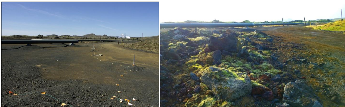
Mynd 4.8 Dæmi um endurheimt hrauns og mosapembu á borplan við Hellisheiðarvirkjun. Hraungjalli og hraunsteinum er komið fyrir og mótað í samræmi við umlykjandi landslag. Mosatorfum og lausum mosa, sem haldið var til haga í upphafi framkvæmda, er komið fyrir í hraungjallinu til endurheimtar á mosapembunum. Mynd: Orka Náttúrunnar, 2022.
