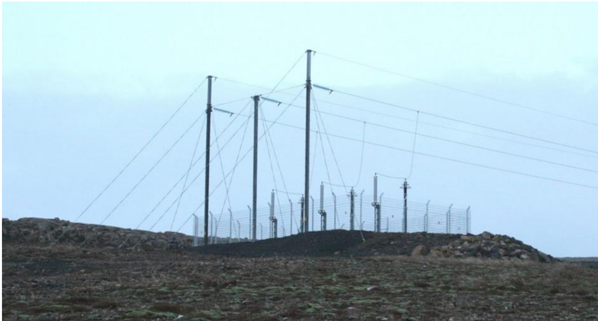
Mynd 5.5 Endavirki fyrir 132 kV jarðstreng í Hnoðraholtslínu 1. Efst eru jarðvírar til að verjast eldingum.
