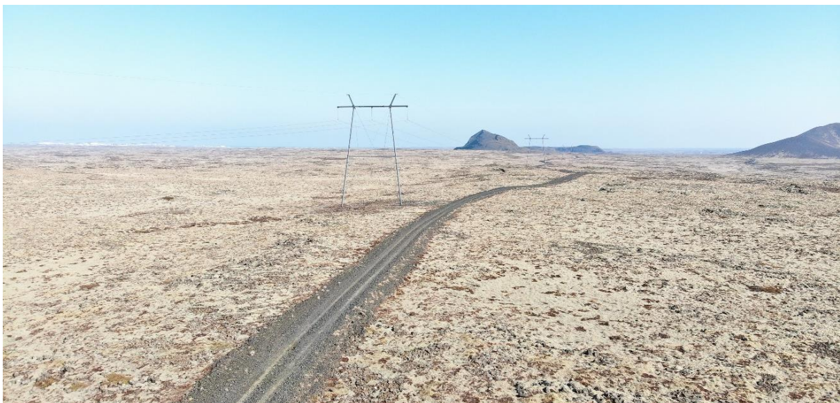
Mynd 5.1 Mynd sýnir mastur á 132 kV línu með jarðvírseyrnum (Rauðamelslína 1). Möstur á stærstum hluta Hvalárlínu og Miðdalslínu verða sambærileg í útliti en flest möstur í línunum verða án jarðvírseyrna.
