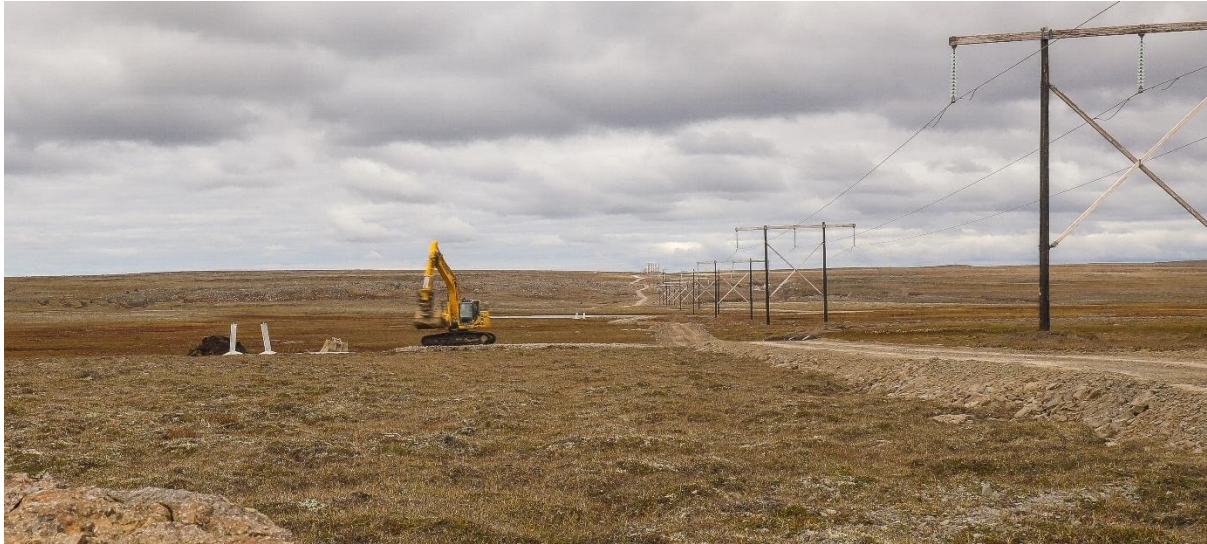
Mynd 5.8. Slóðagerð við Kröflulínu 3. Á myndinni sést núverandi 132 kV loftlína þar sem lögð hefur verið slóð samsíða og undirbúin mastraplön fyrir nýja 220 kV Kröflulínu 3.
