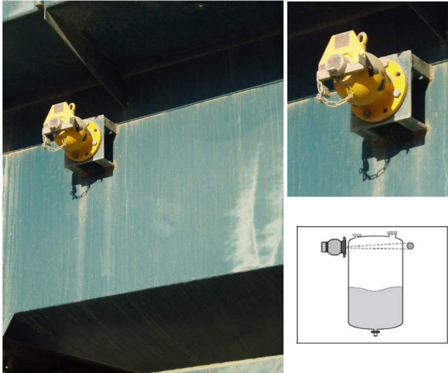
Mynd 7. Geislalind í gulu lindarhúsi, notuð til mælinga á vökvahæð eins og skýringarmyndin sýnir (DSA, birt með leyfi).
