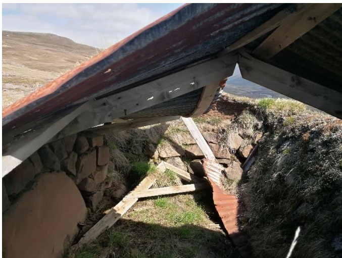
Mynd 6. Hér er horft inn í kofann [2055-5] og inn undir þakið sem er hálffallið. Bárujárníð hefur hvílt á timbursperrum. Neðst til vinstri má sjá náttúrubjarg sem myndar vestur innvegg kofans. Horft er til norðurs.
