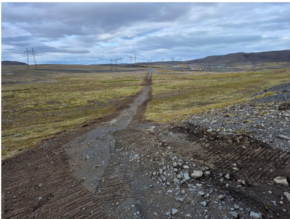
MYND 3.5 Ummerki eftir sambærilegan skurð við Sigöldu strax eftir lagningu vatnsveitu.
