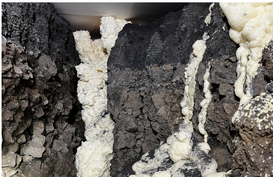
Mynd 19. Dæmi um grautun á fyllingu undir Hópsskóla. Þar náðist að grauta niður á um 6 m dýpi með SILfíll.
