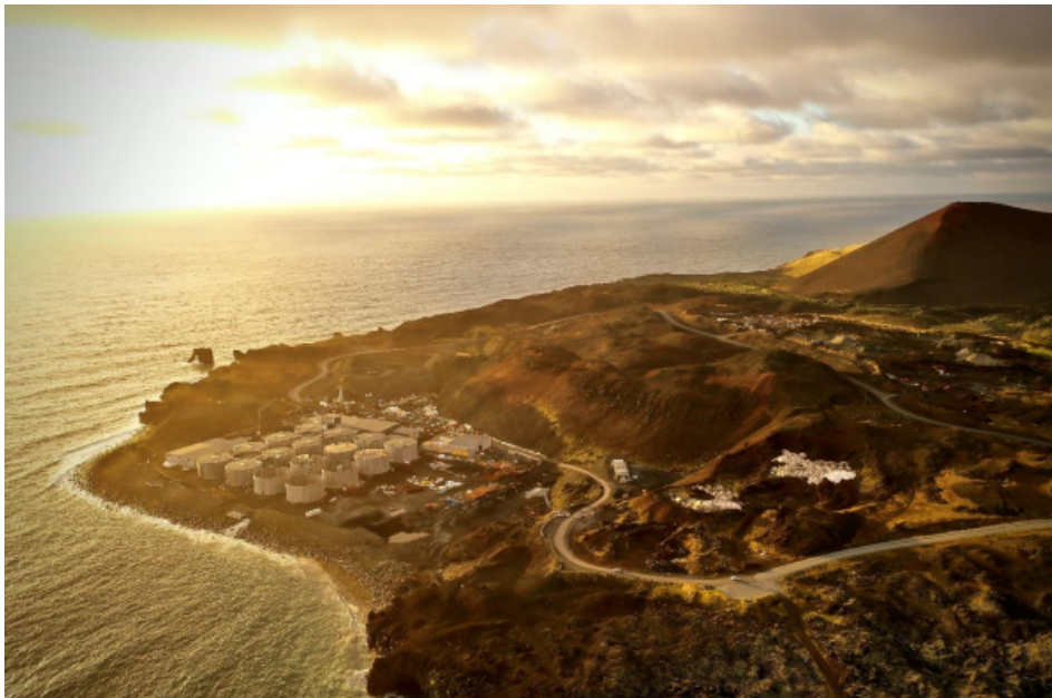
Mynd 3: Yfirlitsmynd yfir fyrirhugað framkvæmdasvæði eins og það er í dag (mynd fengin úr umhverfismatsskýrslu).
