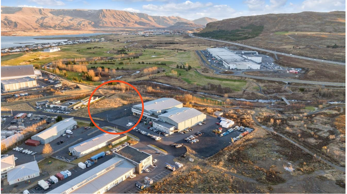
Mynd 2-2 Loftmynd sem sýnir staðsetningu fyrirhugaðrar byggingar og svæðið umhverfis hana.
