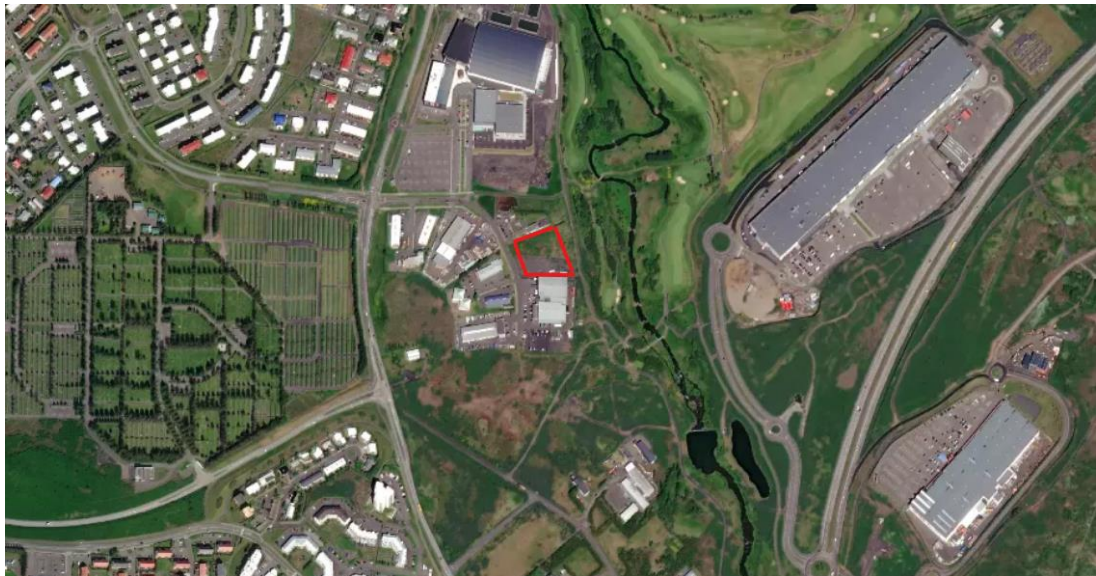
Mynd 1-1 Staðsetning fyrirhugaðs húsnæðis við Fossaleyni í Reykjavík.
