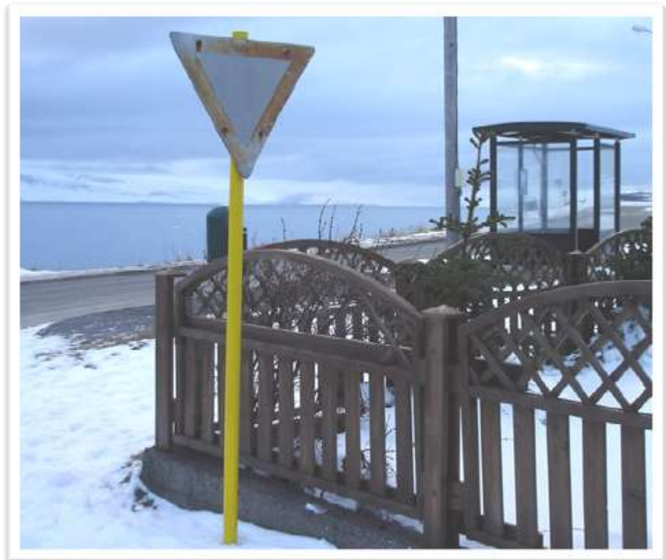
Heiðarbraut til austurs, séð yfir Ísafjarðarveg. Illa farið umferðarskilti.
