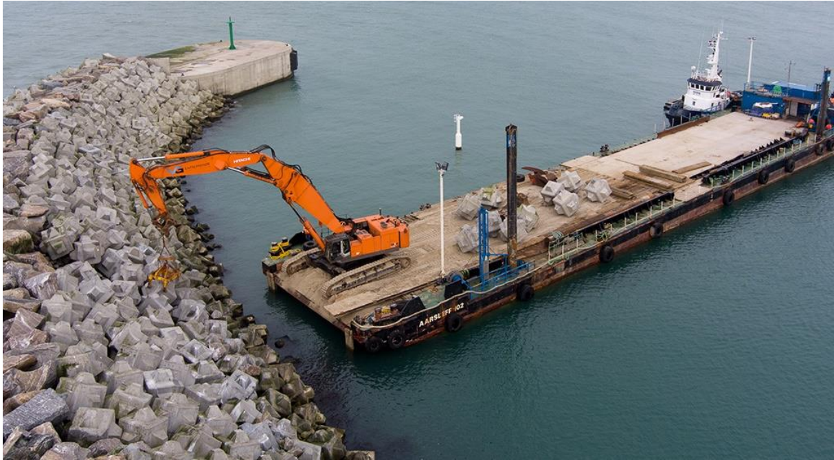
MYND 2.18 Cubipods steypueiningum komið fyrir af pramma. Mynd: Port of Hanstholm
