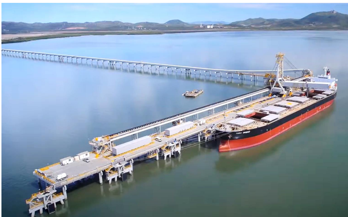
MYND 2.10 Raundæmi um sambærilega bryggju á Wiggins Island Coal Export Terminal á austurströnd Ástralíu. Hér sést þegar verið er að ferma flutningaskip. Skipið hreyfist ekki, heldur löndunarkraninn. Mynd: Wiggins Island Coal Export Terminal
