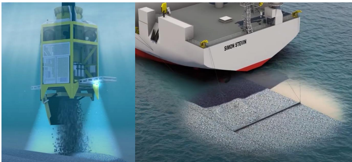
MYND 2.20 Fylling undir steypu einingarnar lögð á sjávarbotninn og yfirborð hennar jafnað. Mynd: DEME Group
