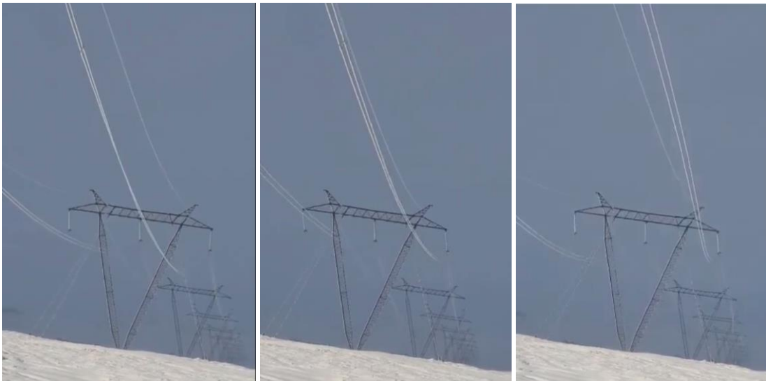
Mynd 51: Leiðari í BU3 á Hellisheiði (tvíleiðari) er hér á mikilli hreyfingu í valhoppi. Eftirfarandi myndir eru teknar á 4 sek. tímabili. Samspil ísingar og vinds framkallar valhopp.
