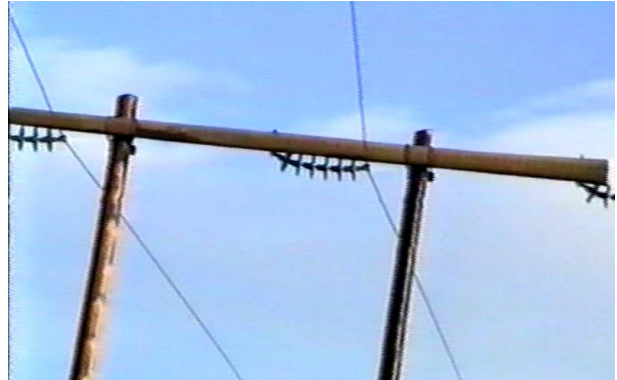
Mynd 19: Mikill vindur og einangrar og leiðarar sveiflast upp í slá, leiðir til útleysingar.
