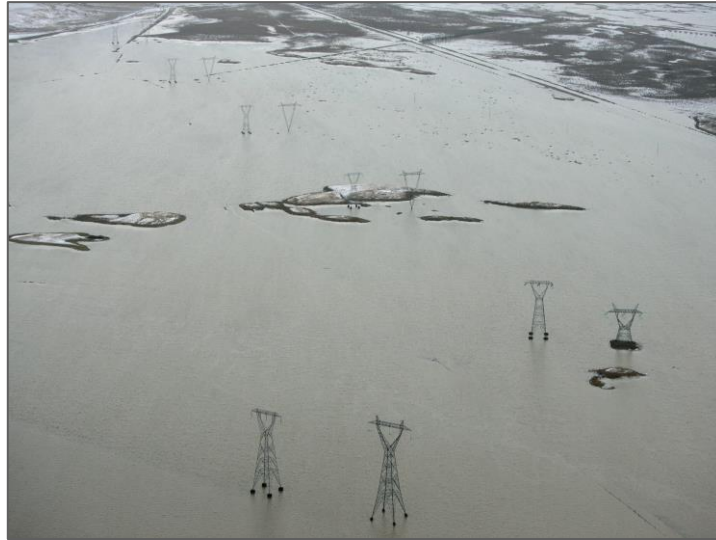
Mynd 43: Flóð í Hvítá. Búrfellslína 1 t.v. og Búrfellslína 3 t.h. Möstrin næst eru á austurbakka Hvítár, horft austur. Möstrin standa á háum undirstöðum og hornið til hægri stendur á upphækkun til að lyfta því upp fyrir flóðmörk.
