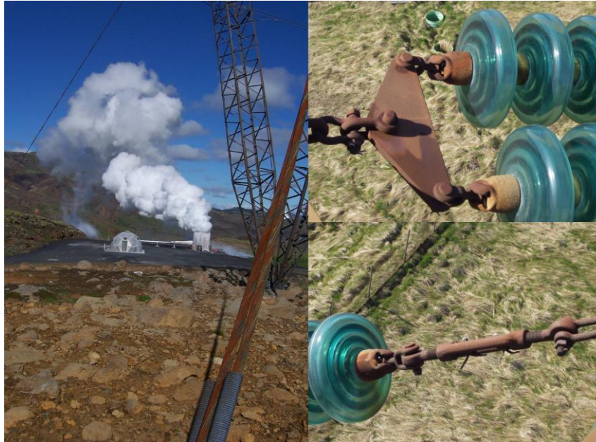
Mynd 54: Tæring á möstrum og upphengibúnaði nærri Hellisheiði. Tæringin stafar af jarðhitagufum, svo sem brennisteinsvetni frá borholum.
