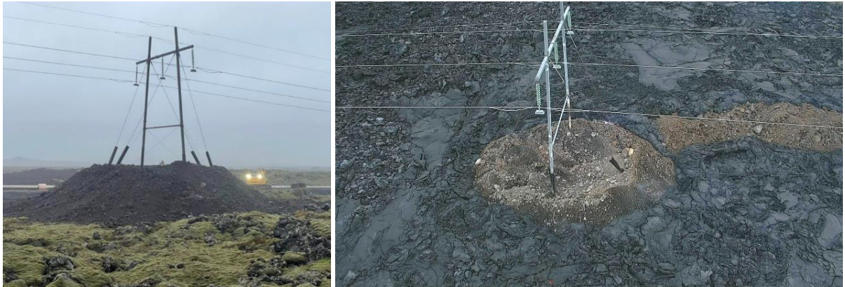
Mynd 36: Mastur í SM1, leiðigarður settur til að verja mastur gegn hraunflæði. Garðurinn virkaði fullkomlega þegar hraun rann að honum 8. febrúar 2024. Leiðari skemmdist ekki vegna hitaáhrifa frá hrauni.
