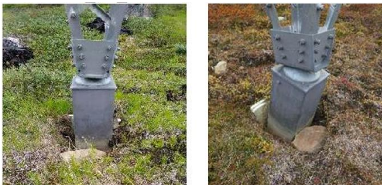
Mynd 49: Færslur á mastraundirstöðu á Grænlandi þegar sífreri byrjaði að þiðna og jarðvegur skreið fram. Myndir eru teknar með þriggja ára millibili. Mastrið hefði fallið ef ekki hefði verið farið strax í aðgerðir.
