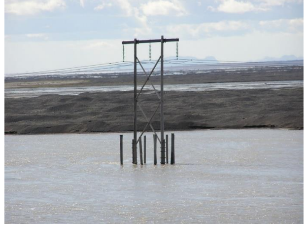
Mynd 39: Grafist hefur frá tvístæðu á niðurreknum staurum, stauravirki til varnar. Prestbakkalína 1.
