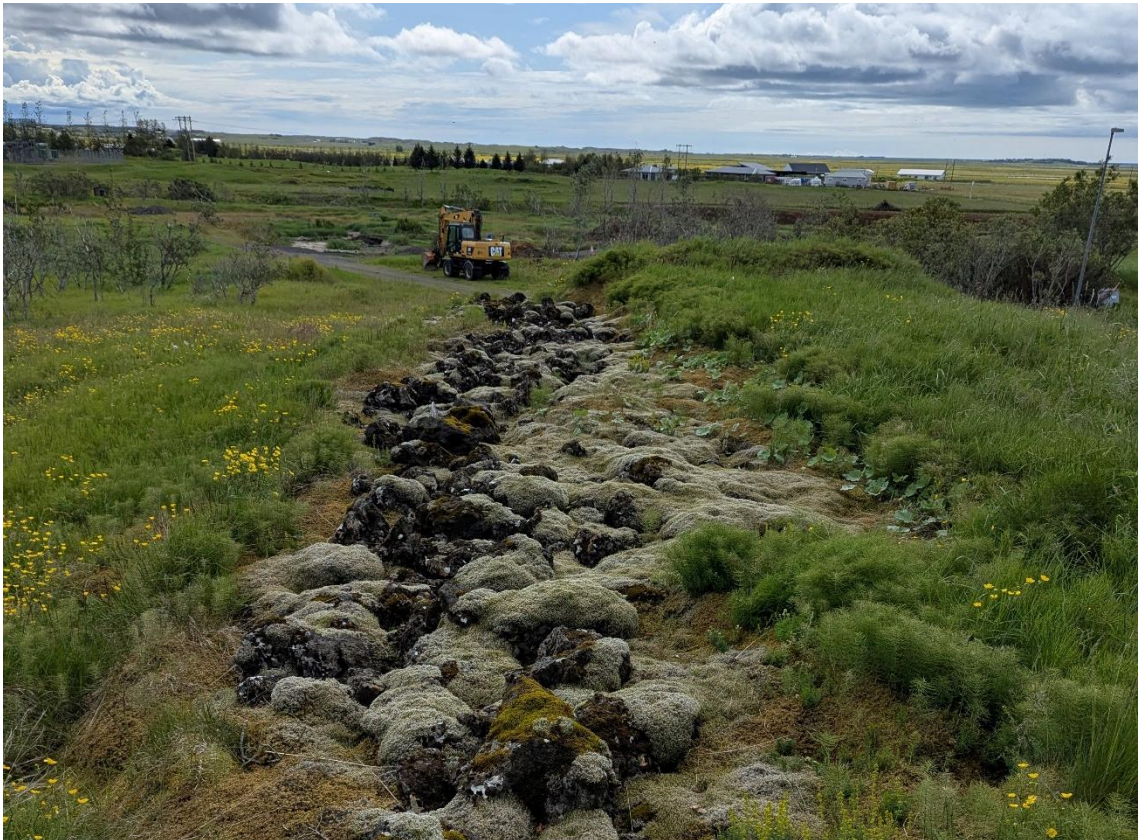
Mynd 2.5 Umhverfi hreinsistöðvar. Horft í suður, norðan við hreinsistöðina. Tengivirki Landsnets og byggingar við Vallaveg austan við Varmá í bakgrunni.
