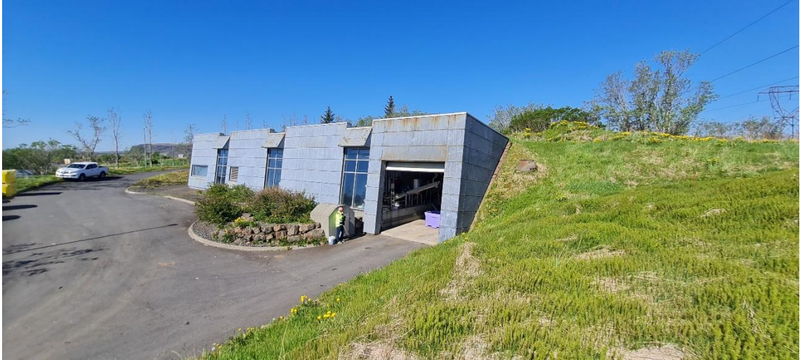
Mynd 2.2 Núverandi bygging hreinsistöðvarinnar
