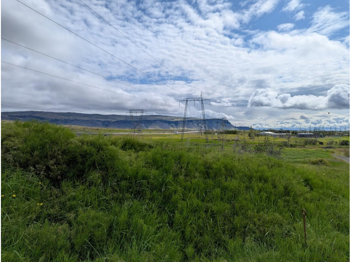
Mynd 2.4 Umhverfi hreinsistöðvar. Horft í austur, norðan við hreinsistöðina. Á myndinni sjást Sogslína 2 og Lækjartúnslína 1, og Suðurlandsvegur í bakgrunni.
