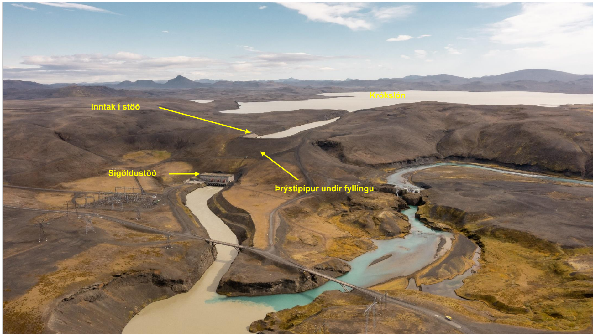
Mynd 4.4 Yfirlitsmynd af Sigöldustöð og nágrenni. Til hægri má sjá hvar yfirfallsvatn rennur um Sigöldugljúfur.
