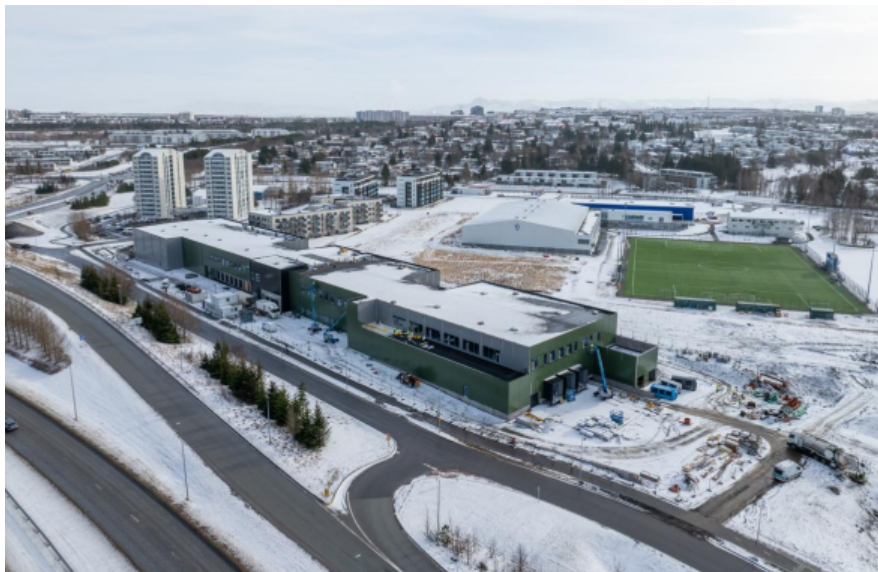
Mynd 2. Myndin sýnir Álfabakka 2a þar sem fyrirhuguð kjötvinnsla Ferskra kjötvara verður staðsett í vesturhluta byggingarinnar.
