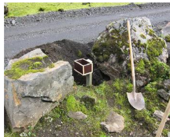
Bifreiðateljara komið fyrir í vegkanti við Eldgjá
