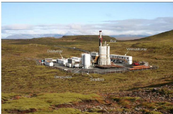
Mynd 2. Dæmi um fyrirkomulag við borun vinnsluholu (Úr umhverfismatsskýrslu).
