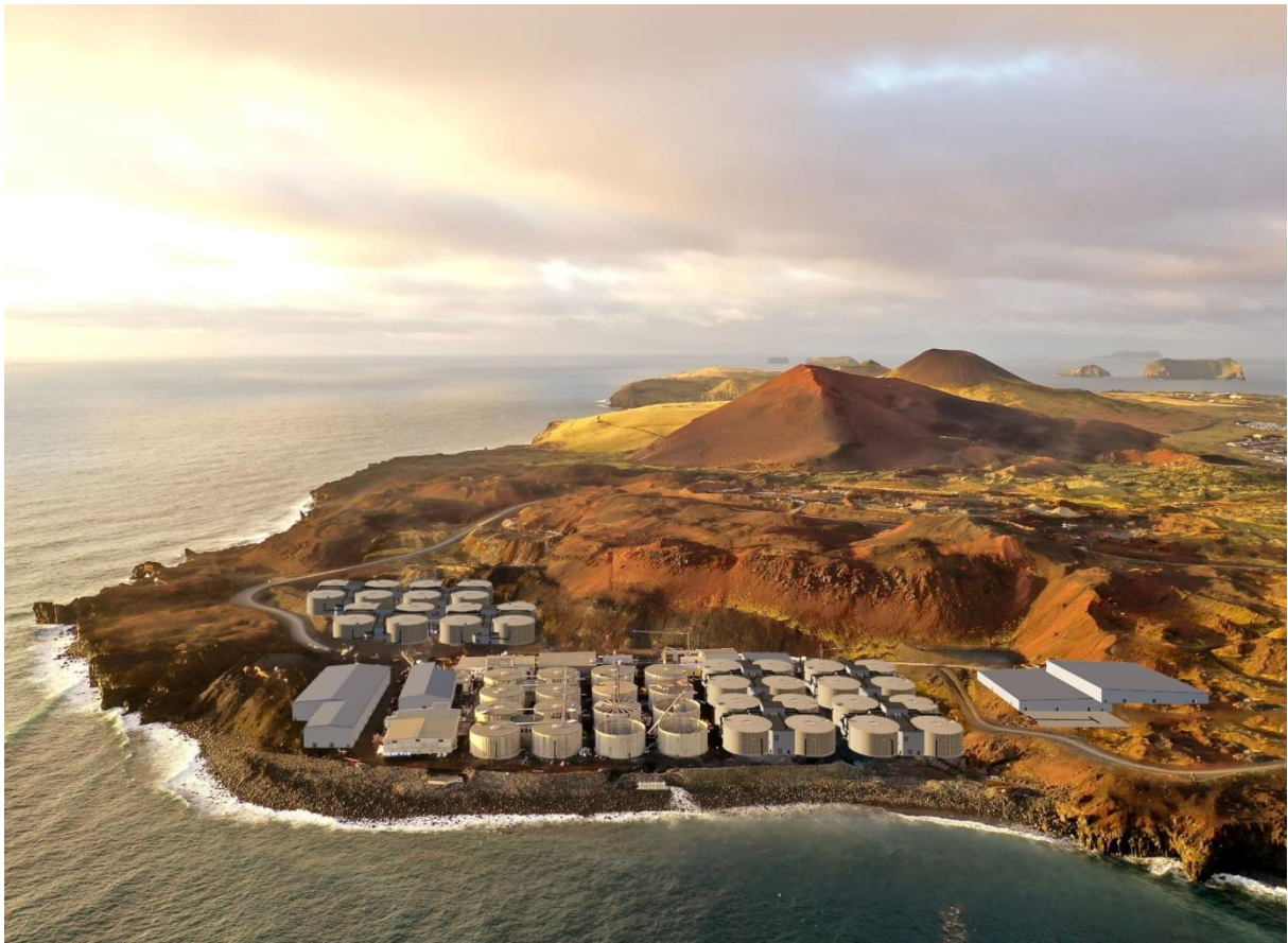
MYND 5.14 Loftmynd af framkvæmdarsvæðinu. Mannvirkjum í tengslum við framkvæmdina hefur verið varpað á myndina.
