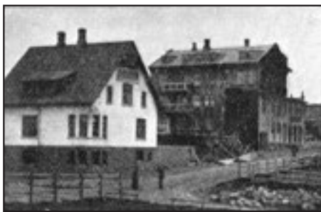
7. mynd. Nýbyggingar í Reykjavík.
