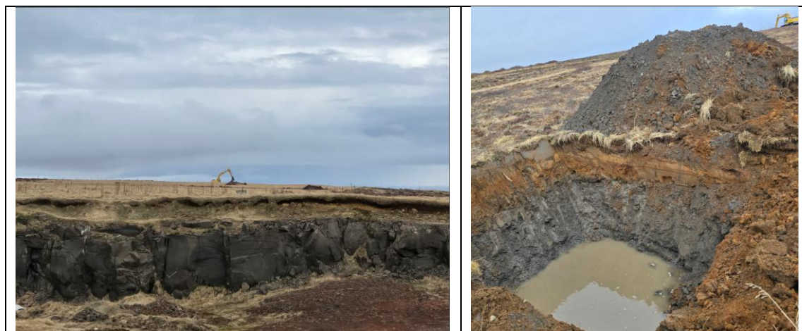
Mynd 31. Dýpi niður á klöpp var að jafnaði milli 2,1 og 2,7 m, þó gynnra í einstaka tilvikum. Á milli efsta moldarlags og klapparinnar er 1 til 2 m lag af jökulruðningi (möl).
