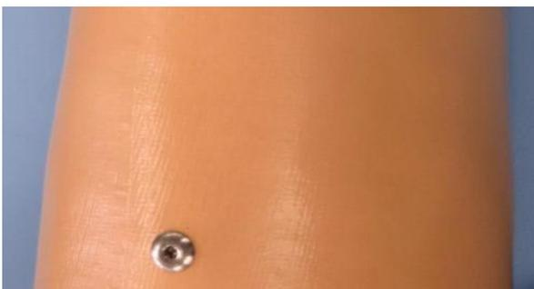
4mmボルト㊟503F3を外ソケットに空けた穴から差込み内ソケットに切ったネジに締めて固定します。
