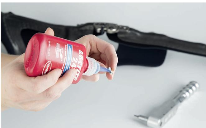
フィッティング後、各継手を最終的に組み立てる際には、ロックタイトでネジを固定してください。
