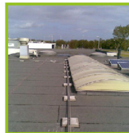
Fout en goed: bekabeling over platte daken dient altijd in UV bestendige (grijze) elektrabuis, kabelgoten of flexbuis te worden aangebracht
