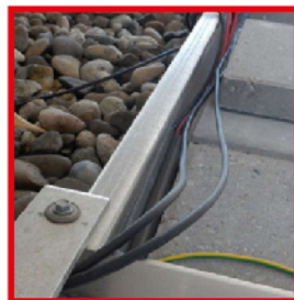
Fout en goed: bekabeling over platte daken dient altijd in UV bestendige (grijze) elektrabuis, kabelgoten of flexbuis te worden aangebracht
