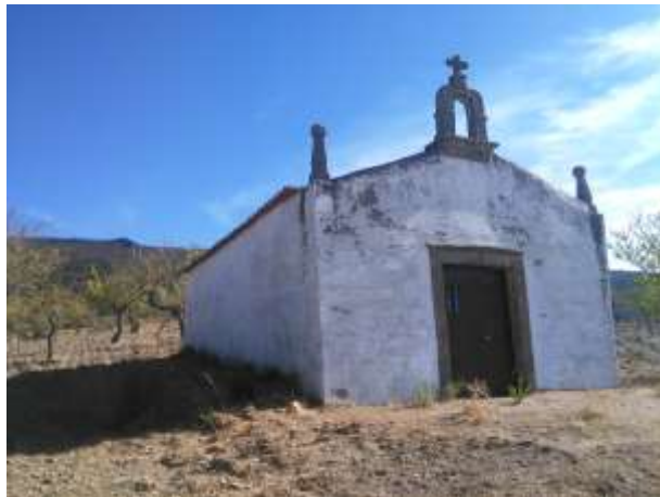
Figura 6: Capela de Maçores
